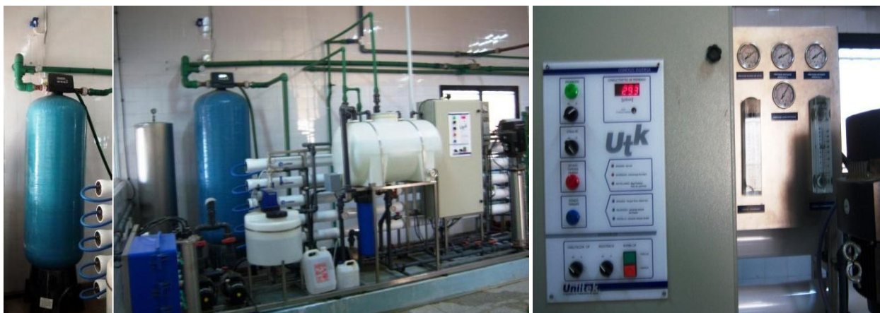
Imágenes: filtro multimedia - equipo de ósmosis inversa - tablero de control de equipo
